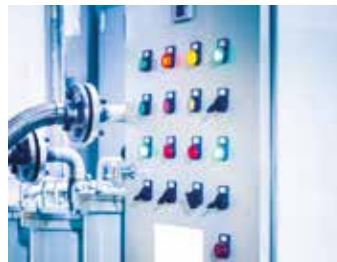
Pompa ve Fan Sistemleri
